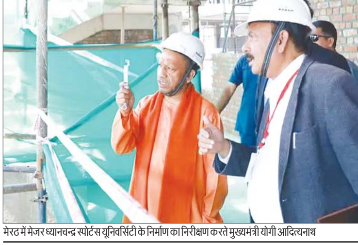
मेरठ में मेजर ध्यानचंद स्पोर्ट्स यूनिवर्सिटी के निर्माण का निरीक्षण करते मुख्यमंत्री योगी आदित्यनाथ
